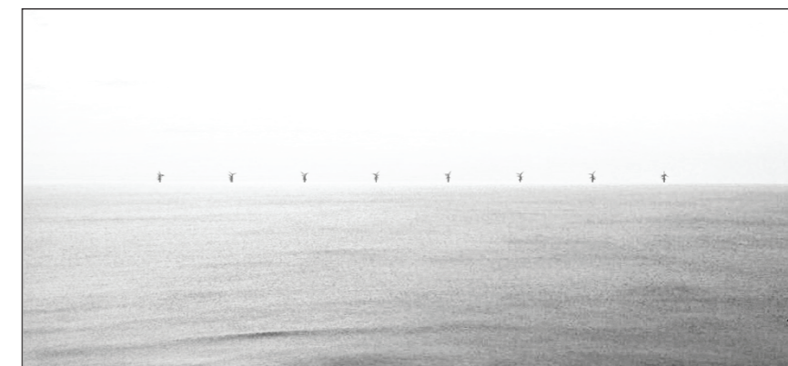
Fig. 12 : Schéma d'implantation « radial » donnant l'illusion d'un alignement équidistant depuis un point de vue précis
